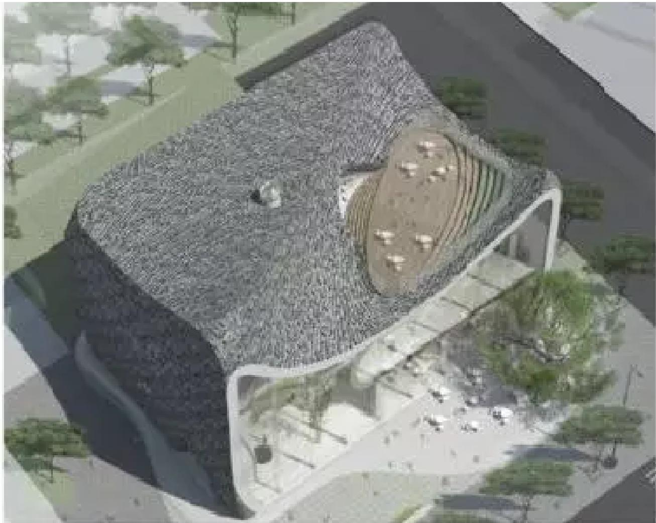
该建筑以博物馆功能为主，主要展厅位于二层和三层。地下一层设置报告厅和可参观式综合机房。建筑在剖面上设置多种天窗、水之腔体、光之腔体以及热压通风通道，光之腔体从屋顶将自然光垂直导向地下报告厅。建筑西南角有一挑高空间连通地上所有楼层，与各层侧窗和屋顶最高点的智能天窗共同实现自然通风。
